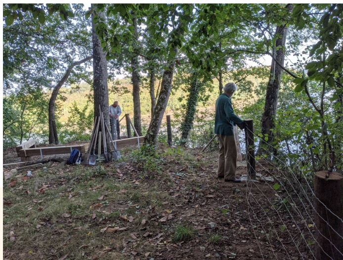
Installation de bancs et sécurisation au Belvédère, au-dessus du Moulin du Prat. Un lieu de quiétude pour admirer la vue sur la Rance.
